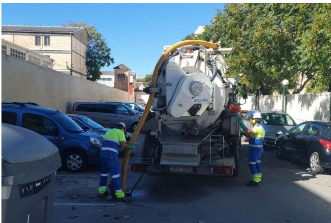
Operarios de Aqualia limpiando alcantarillas en la barriada de La UVA.
