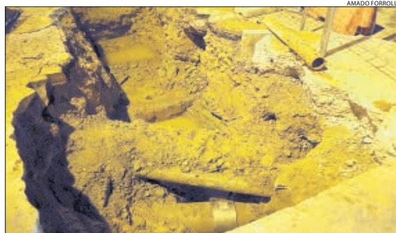
La tubería de La Bordeta afectada, ya reparada.
